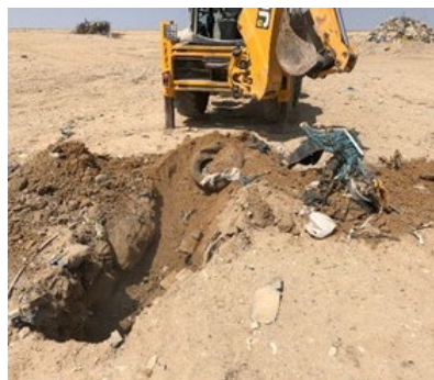
25. אתר פיראטי בנגב שהוסווה בשכבת אדמה דקה. גירוד פני הקרקע חושף את הפסולת שהוטמנה
